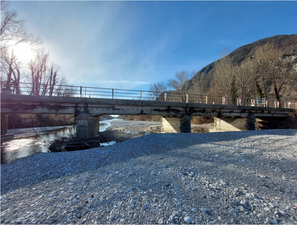
Vista del ponte dal nord con le quattro pile in alveo ed il deposito in dx orografica
