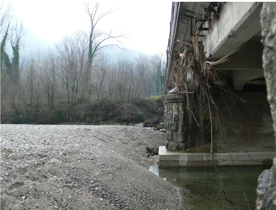
Vista di una pila ed il livello del materiale trattenuto in occasione della piena che ha causato la tracimazione.
